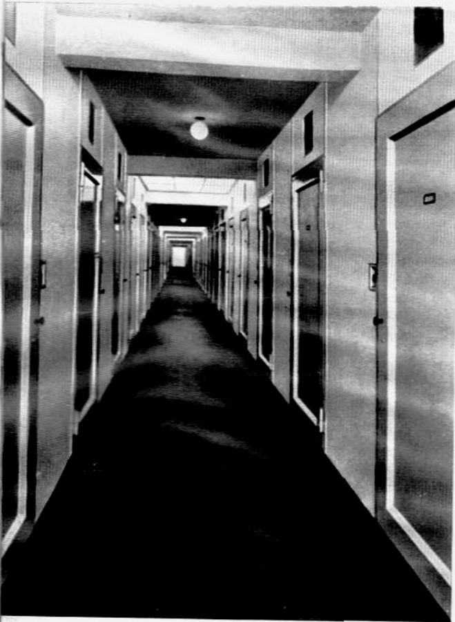
Stahl Türverschlossene Massiv-Kabinen in unserem modernen Kabinen-Möbellagerhaus
