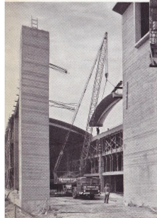
📍 Ankunft der Betonteile auf Spezialfahrzeugen mit entsprechenden Auflagebetten
